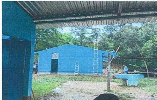
Foto1: INICIO DE LIMPIEZA DE AREA DE TRABAJO
