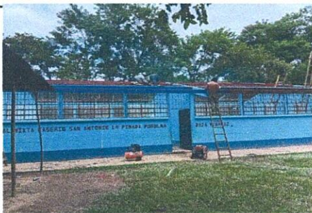
Foto 3: REFORZAMIENTO DE COSTANERAS METALICAS
