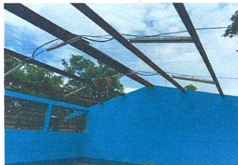
Foto 4: REFORZAMIENTO DE COSTANERAS METALICAS
